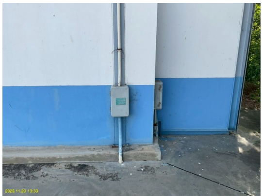
ระบบไฟฟ้าที่ใช้ภายในสถานีก๊าซธรรมชาติหลักเป็นชนิดป้องกันการระเบิด (Explosion Proof) (ต่อ)
