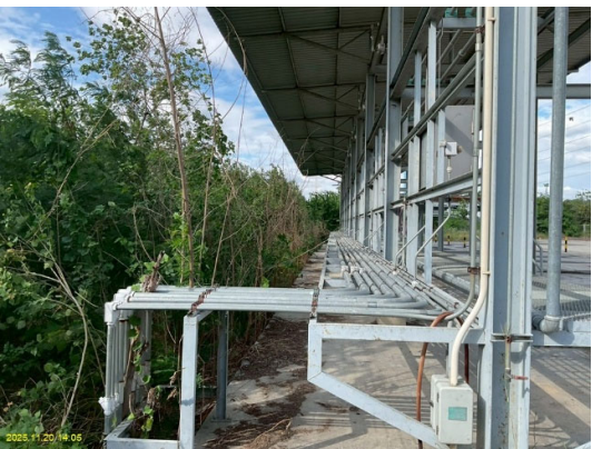
ระบบไฟฟ้าที่ใช้ภายในสถานีก๊าซธรรมชาติหลักเป็นชนิดป้องกันการระเบิด (Explosion Proof) (ต่อ)
